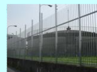
工場外周警備
